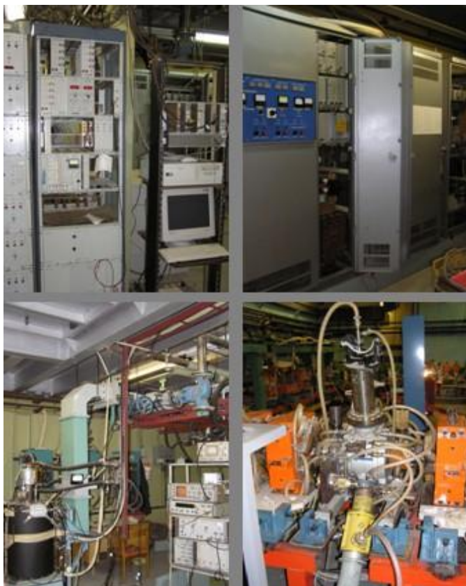
Рис. 2. Элементы ВЧ системы накопителя-охлаждителя: (слева-направо, сверху-вниз) стойка управления ВЧ станции, высоковольтное питание клистрона, клистрон 700 МГц и волноводная система, резонатор накопителя-охлаждителя
